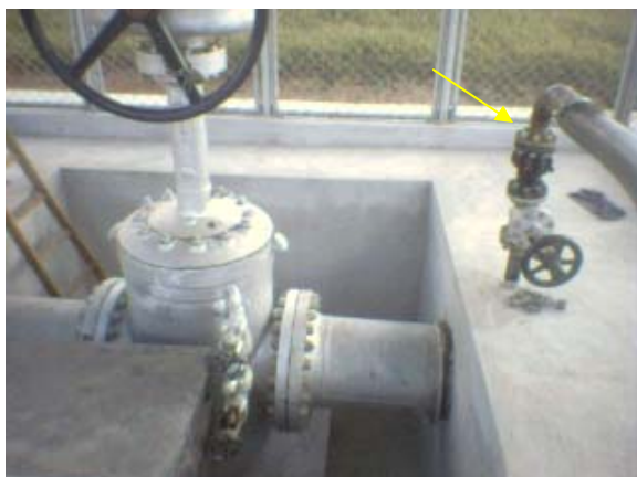
Figura 1. Drenagem usando mangote de abastecimento
